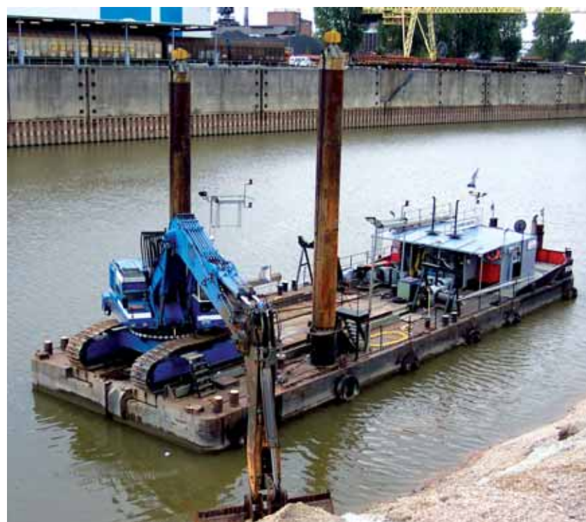
Stelzenpontoon beim Einsatz im Hafengebäude
