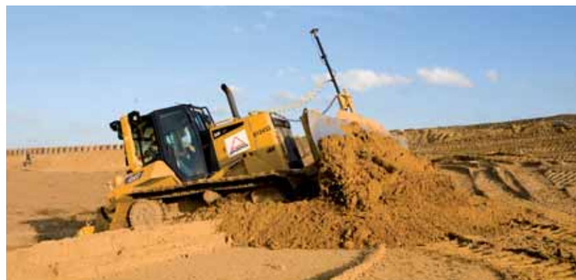
Die neue Flutmulde für den Rhein entsteht GPS-gesteuert
